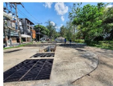
ระบบบำบัดน้ำเสียแบบแบบตะกอนเร่งรวมสมบูรณ์ติดตั้งใต้พื้นคอนกรีต
